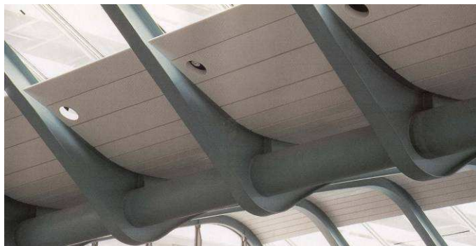
Рис. 5.4. Фрагмент конструкции интерьера KCRC Kowloon Railway Station, Гон Конг, 1995–1997 гг. Н. Фостер
