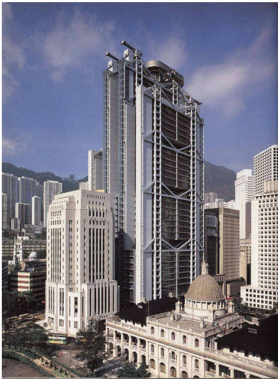
Рис. 5.2. Фасад Hongkong and Shanghai Banking Corporation Headquarters, Гонг Конг, 1981–1986 гг. Н. Фостер
