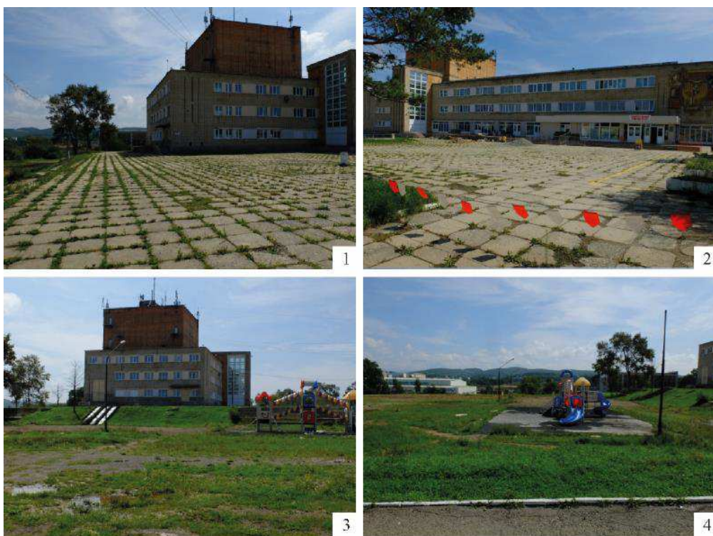
Рис. 3.4. Фотографическая фиксация современного состояния территории у Дворца культуры «Звезда» в г. Большой Камень выполнена студентами 4-го курса: 1, 2 – площадь перед зданием на верхней террасе; 3, 4 – нижняя терраса
