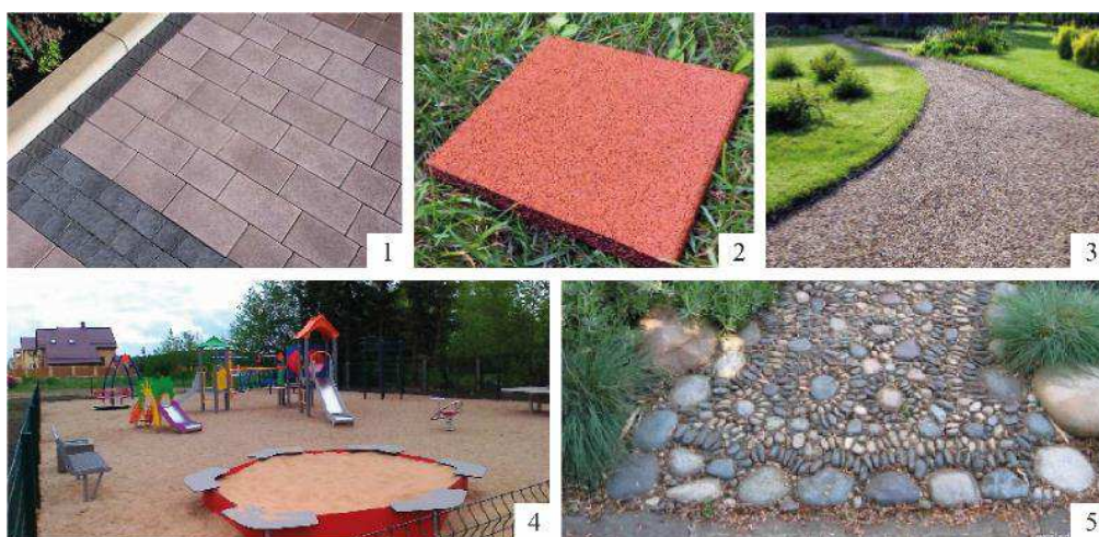
Рис. 2.29. Покрытия проездов, дорожек и площадок, предложенные в проекте: 1 – брусчатка; 2 – защитное покрытие из резиновой крошки; 3 – отсыпка из гравийной крошки; 4 – песок мелкий просеянный; 5 – покрытие из гальки. КР магистранта Анны Якушевой. Преподаватель А.В. Копьёва, 2020 г.
