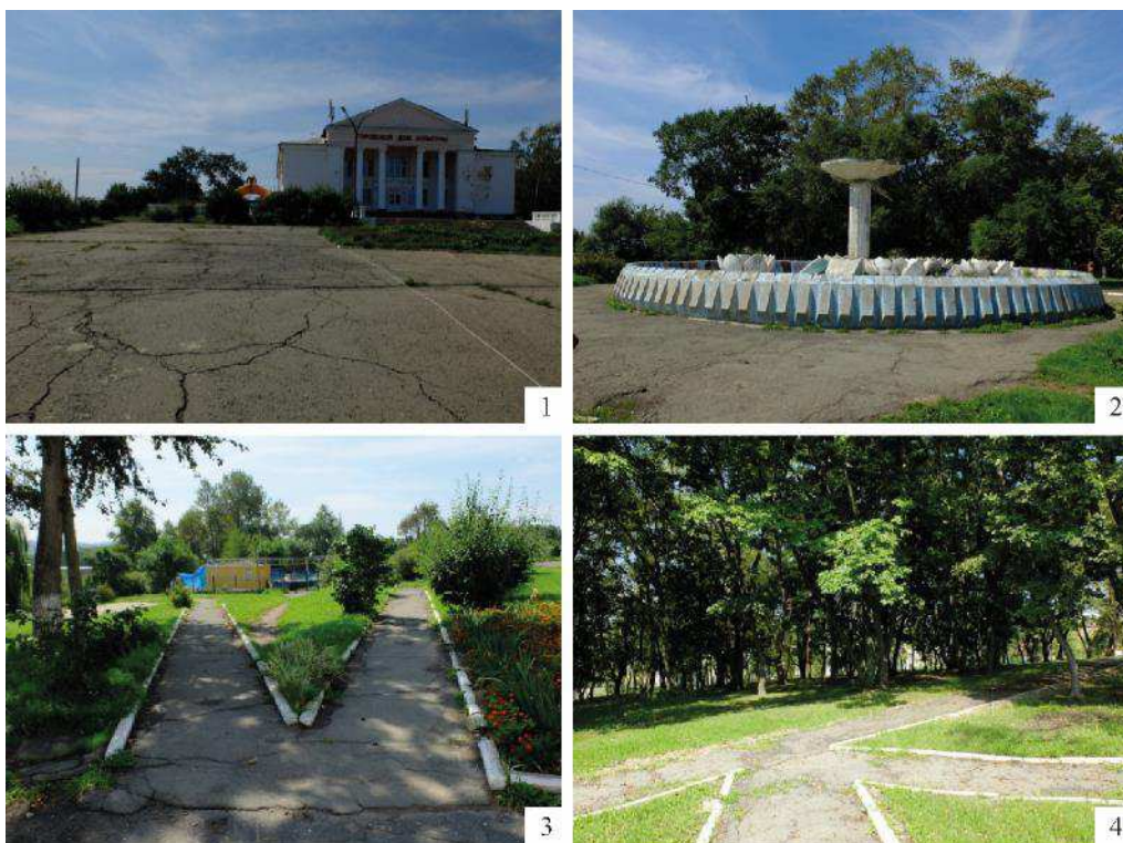
Рис. 3.2. Фотографическая фиксация современного состояния парка городского Центра культуры в г. Большой Камень выполнена студентами 4-го курса: 1 – вид на Дом культуры; 2 – вид на центральную площадь парка; 3 – вид на главные аллеи парка; 4 – вид на прогулочные дорожки
